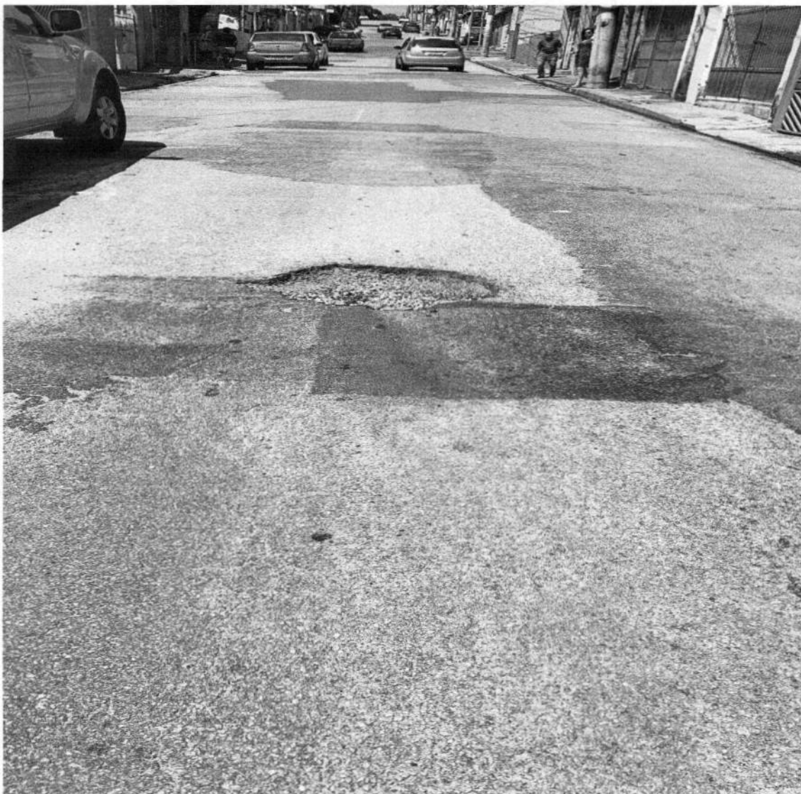
MANUTENÇÃO ASFÁLTICA NA RUA MÁRIO YOSHIDA, EM FRENTE A CASA DE NÚMERO 217, BRÁS CUBAS – MOGI DAS CRUZES.
